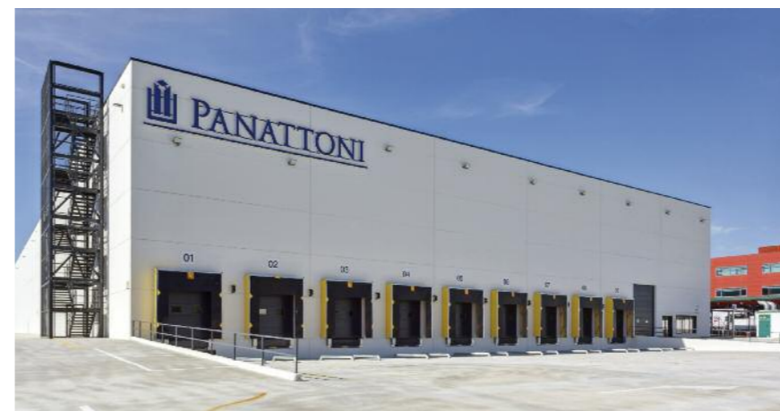
Panattoni Park Getafe, con 9.200m 2 de superficie, ha sido recientemente alquilado.
