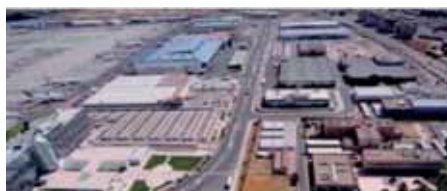
Centro de Carga Aérea de Barajas.
