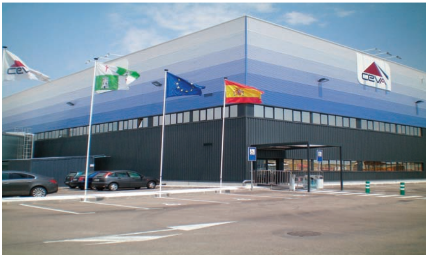
Ceva Logistics cuenta con unas modernas instalaciones en Ontígola (Guadalajara).
