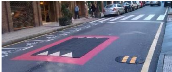
Badén tipo "Cojín Berlínés" previo al paso de peatones. Fuente: Plan30 Oviedo
