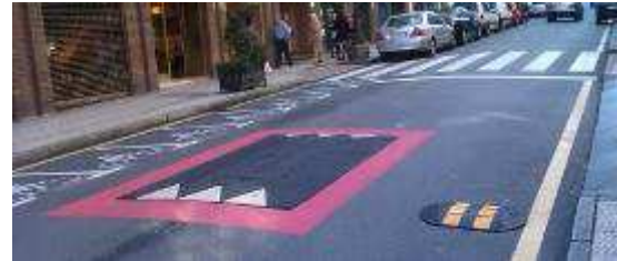
Badén tipo "Cojín Berlín" previo al paso de peatones. Fuente: Plan30 Oviedo
