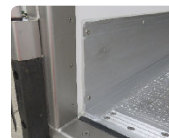
Goma rotura puente térmico y perfil de aluminio transición a piso
